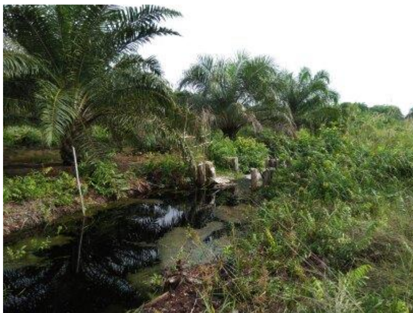
写真 1 : 排水路内の小規模ダム(写真中央部)
