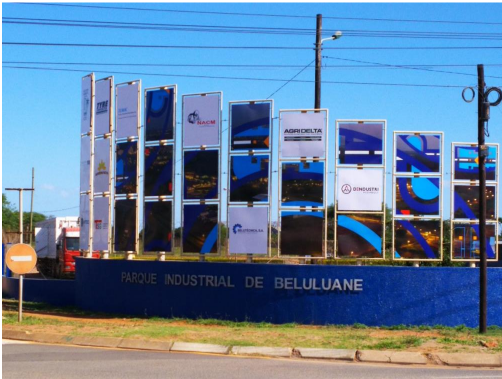
マプト県ボアネ郡ベルルアーネ経済特区内に立地するベルルアーネ工業団地
