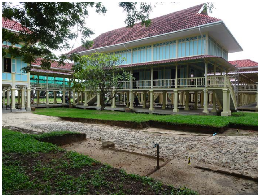
修復中の宮殿と発掘調査中の道路
