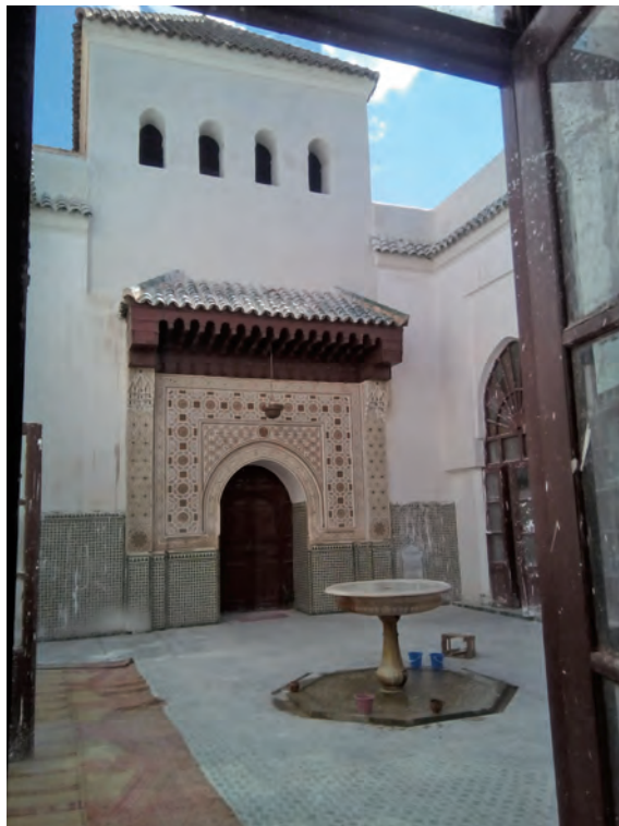
写真2：ムハンマド・イブン・スライマーン・ジャズーリー廟（工事中）
