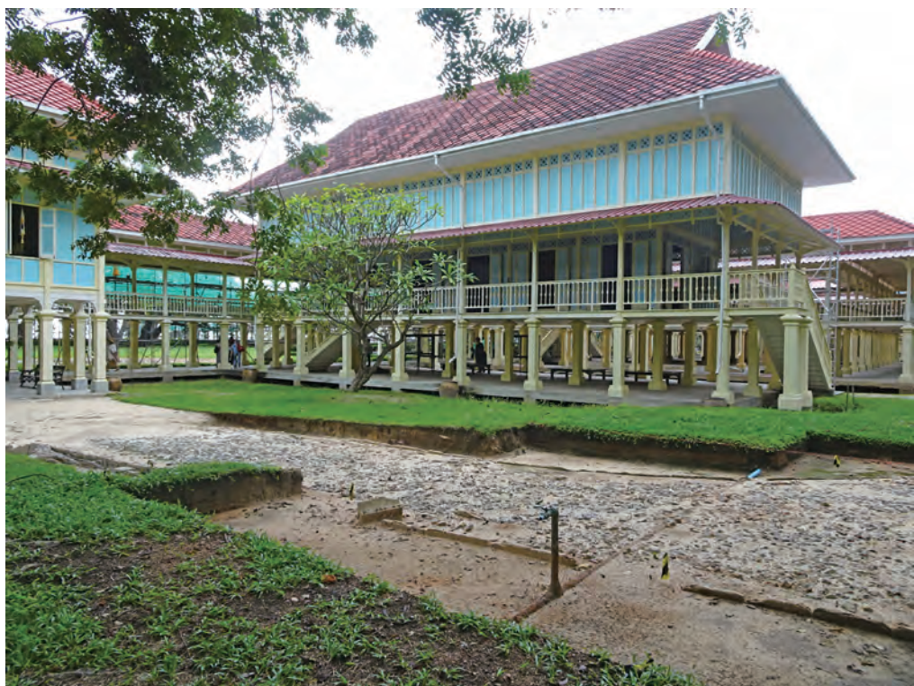
写真2：修復中の宮殿と発掘調査中の道路
