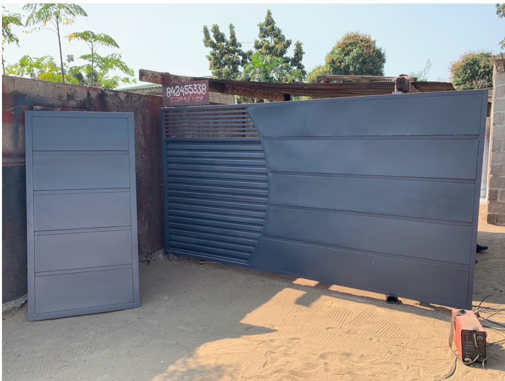
写真 2 製作中の門扉(マトラ市)
