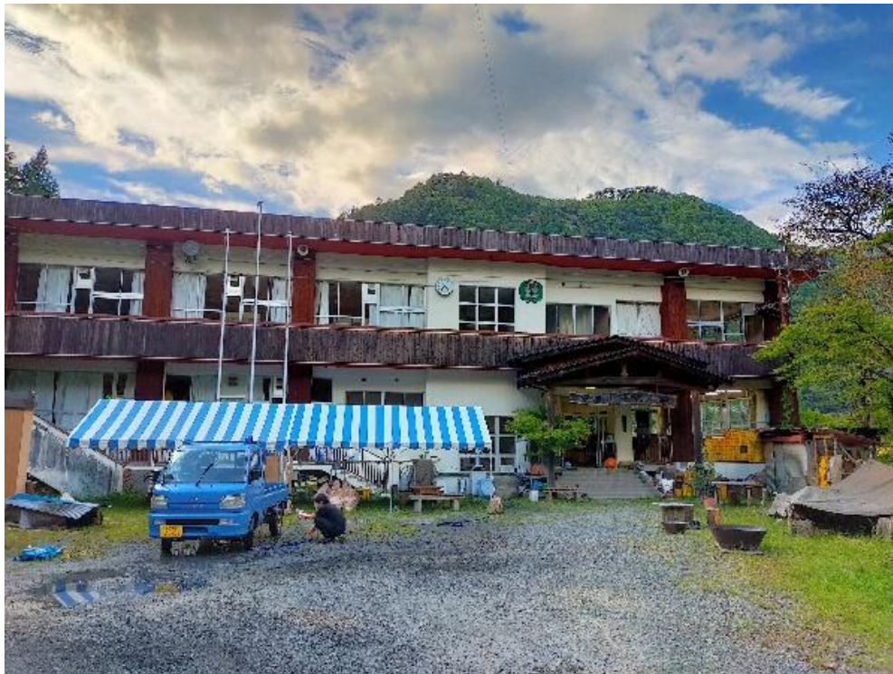
小学校を改装して作られた NPO 法人多摩源流こすげの事務所
