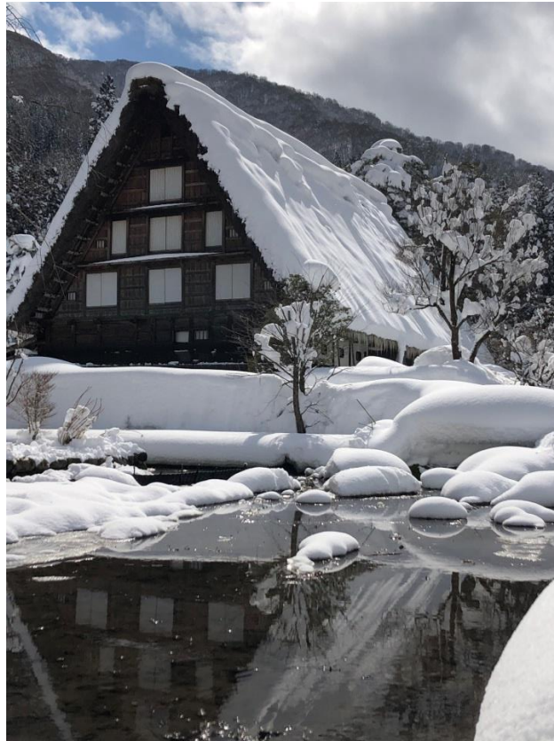
写真2 荻町最大級の五階建て合掌造り家屋の外観
