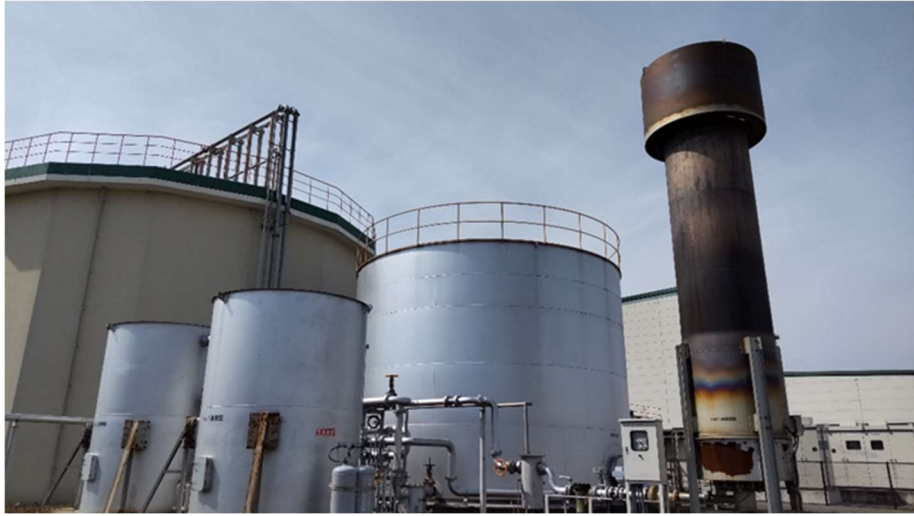
写真1：神立資源リサイクルセンターのメタン発酵槽（左奥）（報告者撮影）
