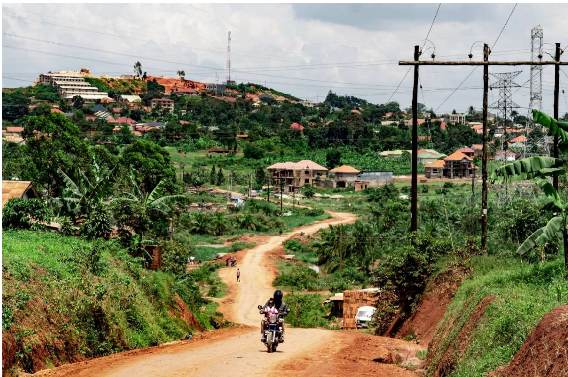
写真2：中心部から20kmほど離れたカンパラ都市圏の外縁部。低地には焼きレンガが積まれ、今まさに家屋が建設されている。(2022年10月 報告者撮影)
