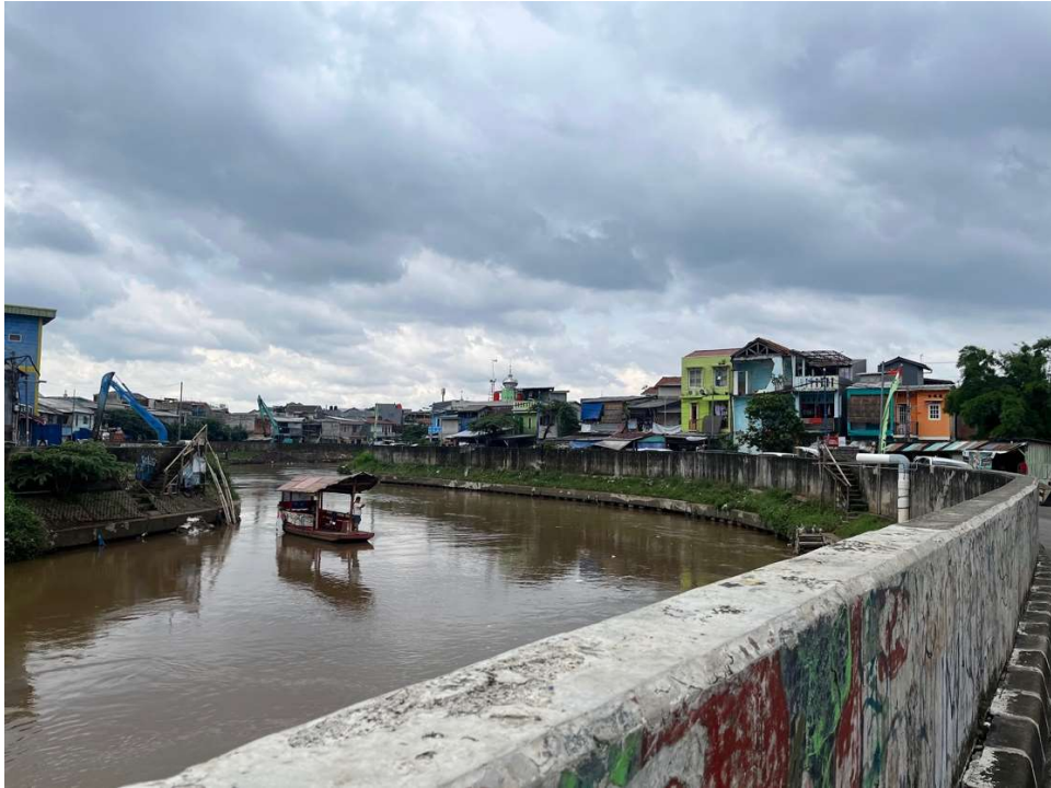
堤防が建設されたカンプムラユ地区
